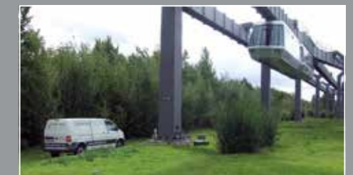
Ankerbolzenwartung und Messung der Restvorspannkräfte
