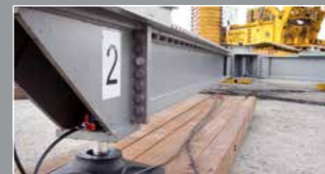
Anheben und Nivellieren schwerer Lasten mit Hochdruck Hydraulik
