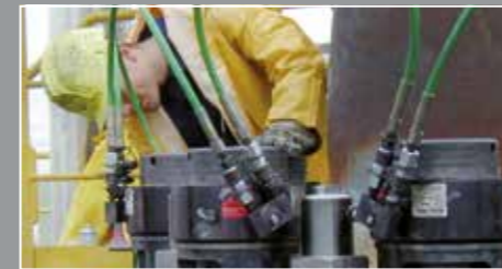
Öffnen und Schließen von Druckbehältern mit Schraubenspannvorrichtungen
