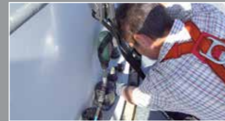
Ankerbolzenmontage mit Schraubenspannvorrichtungen
